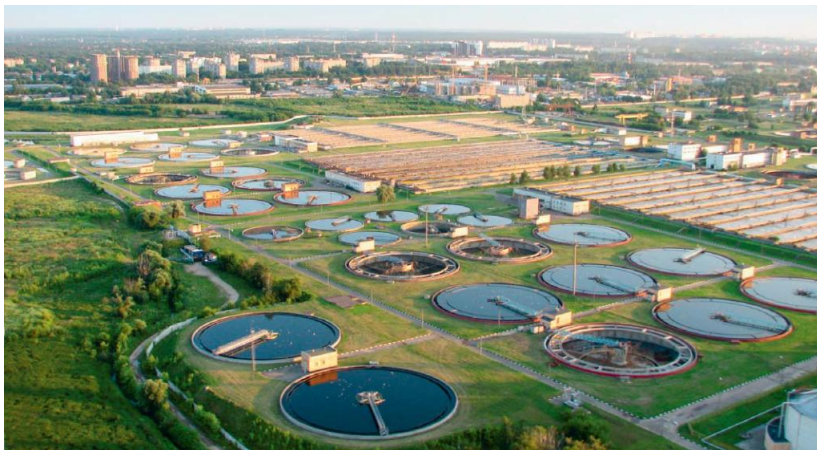
Рис. 127. Сооружения по очистке воды
